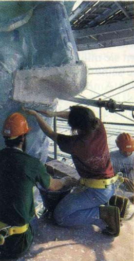
**Die Freiheitsstatue wird renoviert. Die Kupferhaut mußte gereinigt und teilweise repariert werden. Eine neue goldbelegte Fackel hat die alte ersetzt. Vor allem mußte das von Rost befallene innere Gerüst erneuert werden.**
