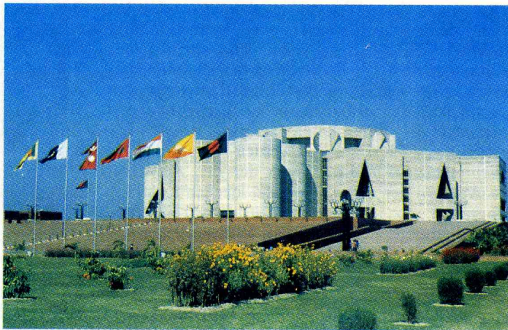
Das Gebäude der Nationalsammlung in Dhaka, Bangladesch — Tagungsort der historischen Gipfelkonferenz Südasiens.
