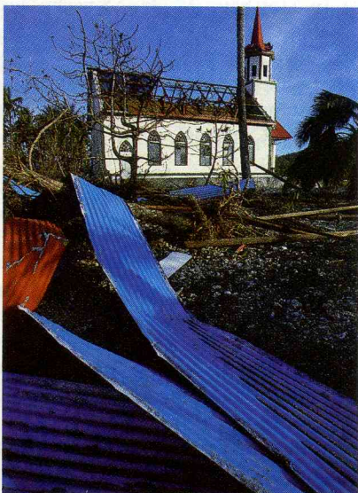
Schäden des Zyklons Veena (Tahiti).
